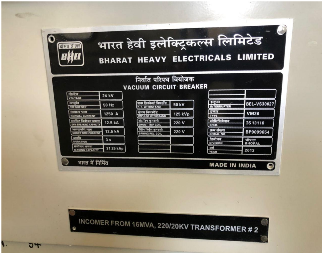
تصویر 8: قلم شماره 8 (Incoming Feeder circuit breaker) سب ستیشن پشتہ سرخ - پروان برشنا
