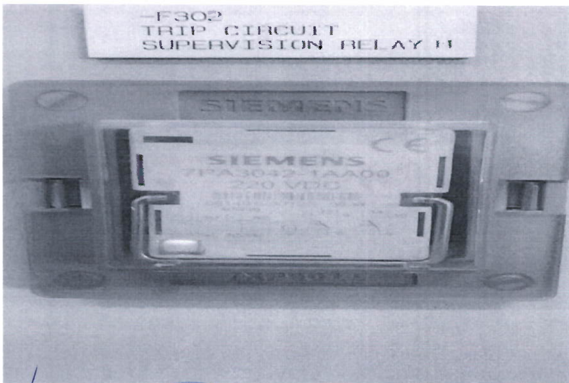
تصویر 9: قلم شماره 11 (Supervision Relay) سب ستیشن بتخاک - کابل برشنا
