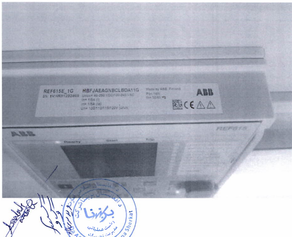
تصویر 6: قلم شماره 6 (Relay for 20kV) - سب ستیشن پل علم - لوگر برشنا
